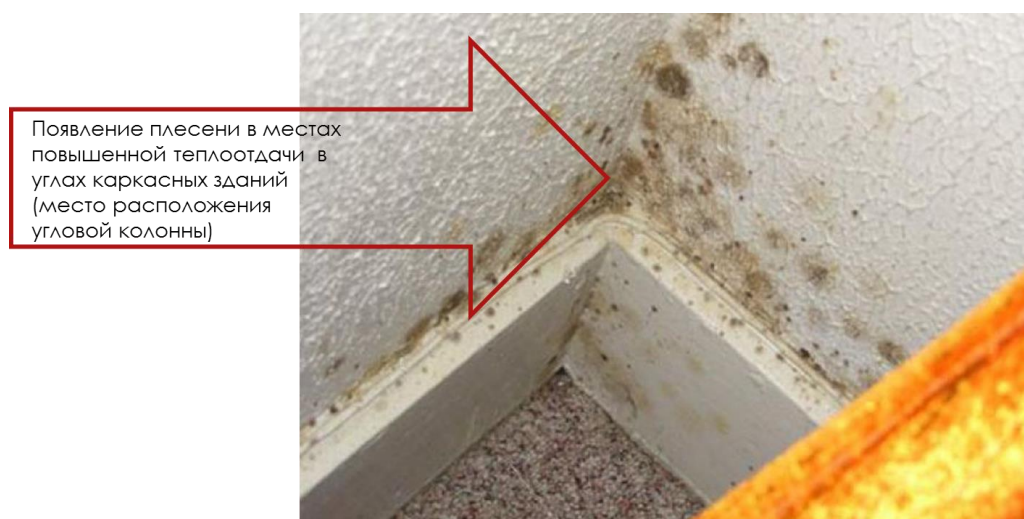
Рисунок 2 – Появление конденсата и впоследствии плесени в местах пониженных температур
