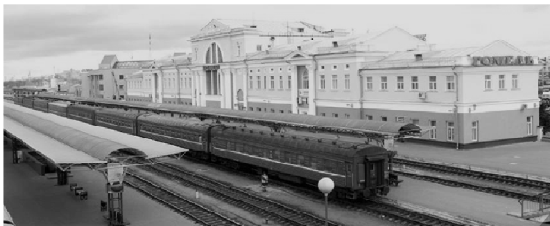
Рисунок 1. Железнодорожный вокзал в г. Гомеле
