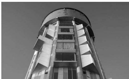
Рисунок 5. Водонапорная башня в Йогерсборге: встроенные жилые «капсулы»
