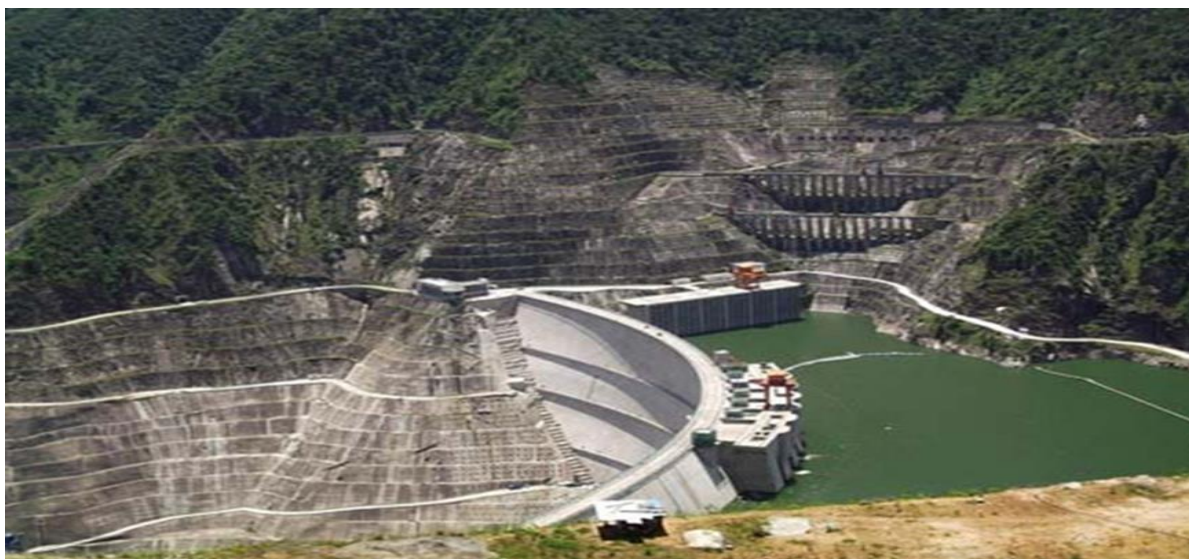
Рисунок 6 – Аоганг плотина в Китае
