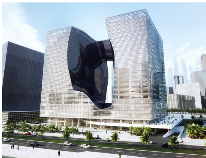
Рисунок 14 – Торгово-офисный комплекс «The Opus», Дубай (ОАЭ)
