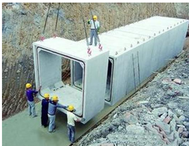
Рисунки 2 – Использование напрягающего бетона при изготовлении труб
