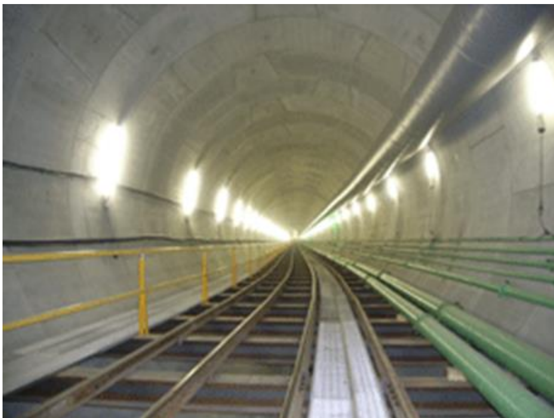
Рисунок 11 – Отделка тоннелей метро
