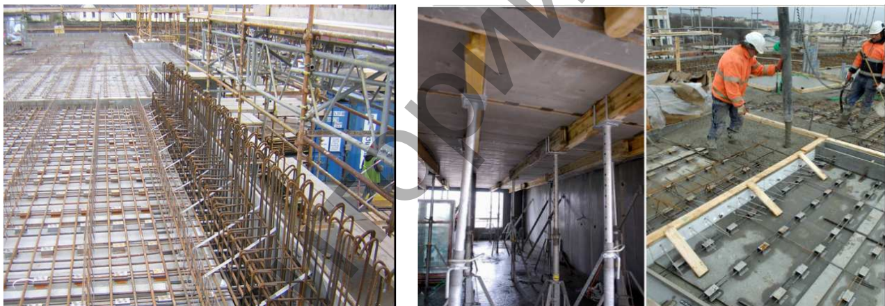
Рисунок 1 – Применение VST-системы перекрытий зданий
