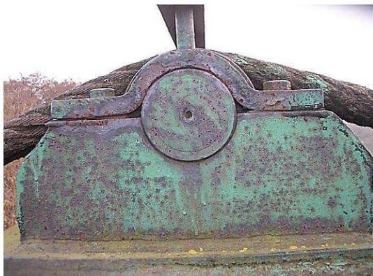
Рис. 2. Общий вид оголовка пилонов и опорных катков
