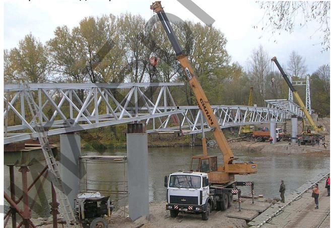
Рис. 7. Монтаж центрального пролета моста длиной 60 м двумя кранами ДЭК-251
