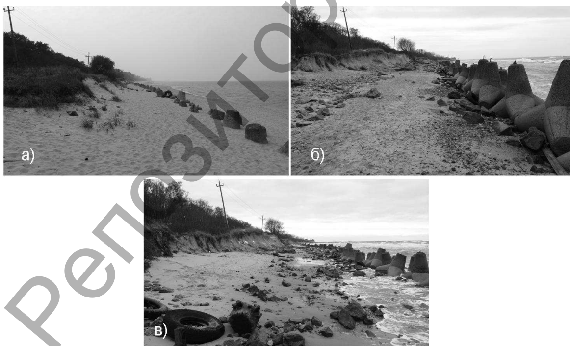
Рисунок 3 – Результат волнового размыва берега у корня Куршской косы (р-н Зеленоградска):
