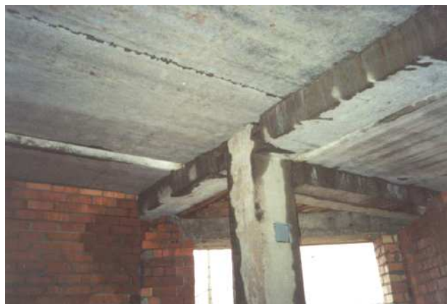
Рис. 2. Балочное сборное перекрытие
