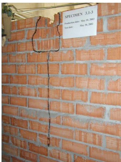
Рис. 3. Характер разрушения образцов.
