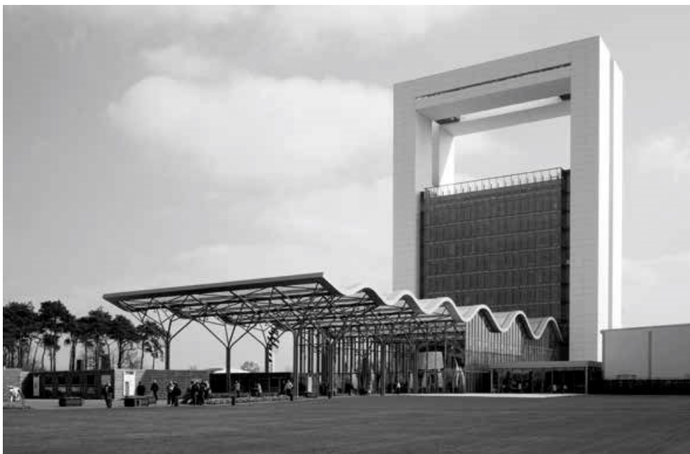
Рисунок 11 – Офисное здание в г. Венло, JCAU Jo Coenen Architects & Urbanists, 2011 г.
