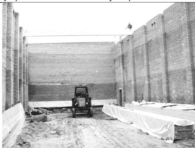
Рис. 6. Фрагмент покрытия спортзала
