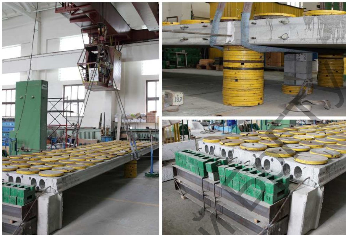
Рисунок 3 – Начальное состояние опытного фрагмента диска перекрытия
