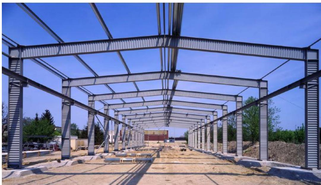
**Рисунок 1 – Стальной каркас здания из двутавровых стержней с гофрированной стенкой**
