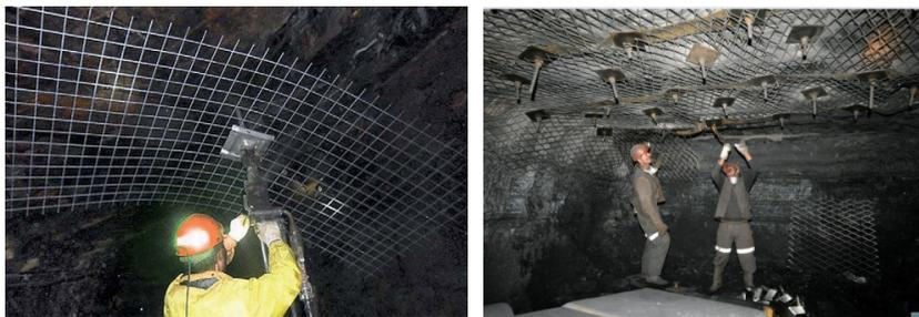
Рисунок 2. Установка анкерного крепления
