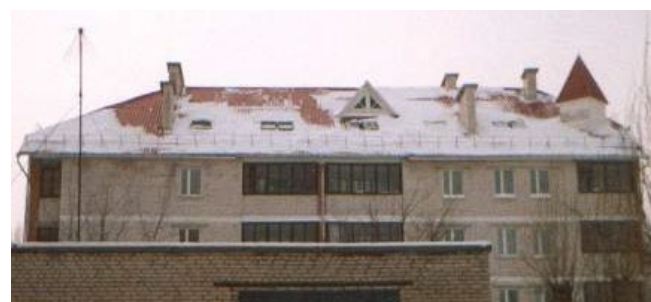
Рис. 7. Распределение снега на кровле с уклоном \leq 45^\circ
