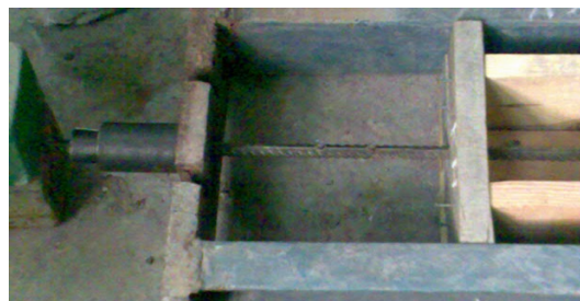
Рис. 1. Натяжение арматуры гидродомкратом (а) и способ закрепления на торцах силовой рамы (б)
