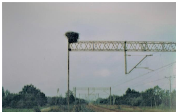
Fot. 9. Gniazdo na bramce trakcyjnej kolei elektrycznej (fot. M. Piotrowska)
