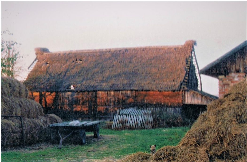
Fot. 2. Gniazda na słomianym dachu (fot. M. Piotrowska)
