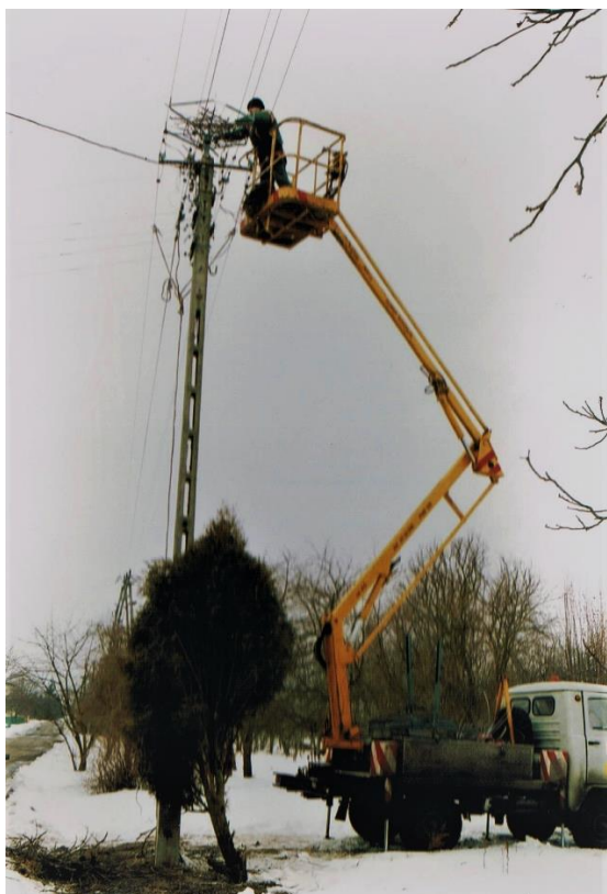
Fot. 5. Pracownicy Zakładu Energetycznego montujący podstawę pod gniazdo (fot. M. Piotrowska)
