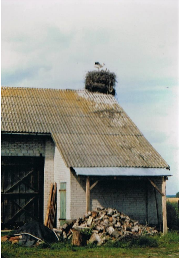
Fot. 3. Gniazdo na dachu krytym eternitem (fot. M. Piotrowska)
