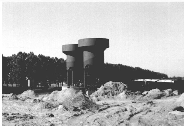
Рисунок 2 - Гидроциклоны, работающие на локальных очистных сооружениях Пружанского молочного комбината
