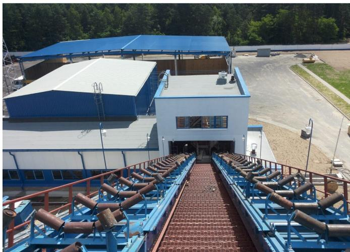
Рис. 4 – Конвейер топливоподачи Лунинецкой ТЭЦ
