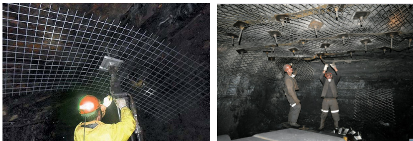
Рисунок 2. Установка анкерного крепления
