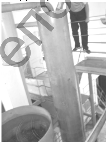
Рисунок 4 - Пенополистирольные фильтры с технологическими трубопроводами
