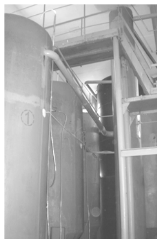
Рисунок 4 - Пенополистирольные фильтры с технологическими трубопроводами
