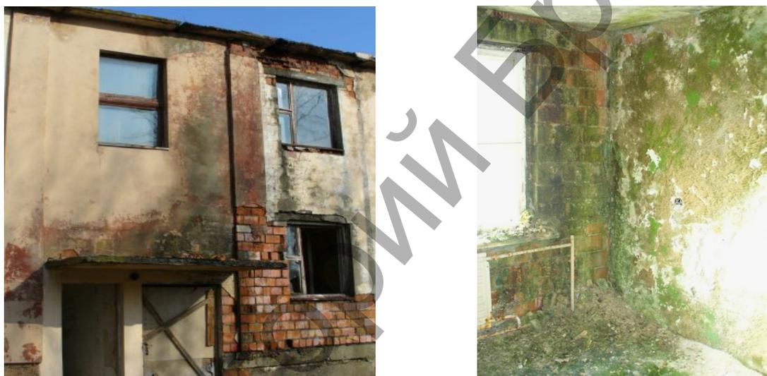
Рисунок VI.4 – Переувлажнение кладки стен
