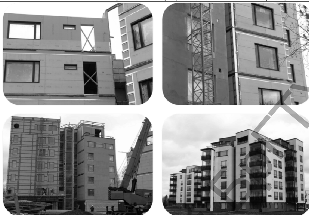
Рис. 1. Квартальная застройка с применением легких панелей в сборно-монокорпусе 5–6-этажных зданий в Финляндии
