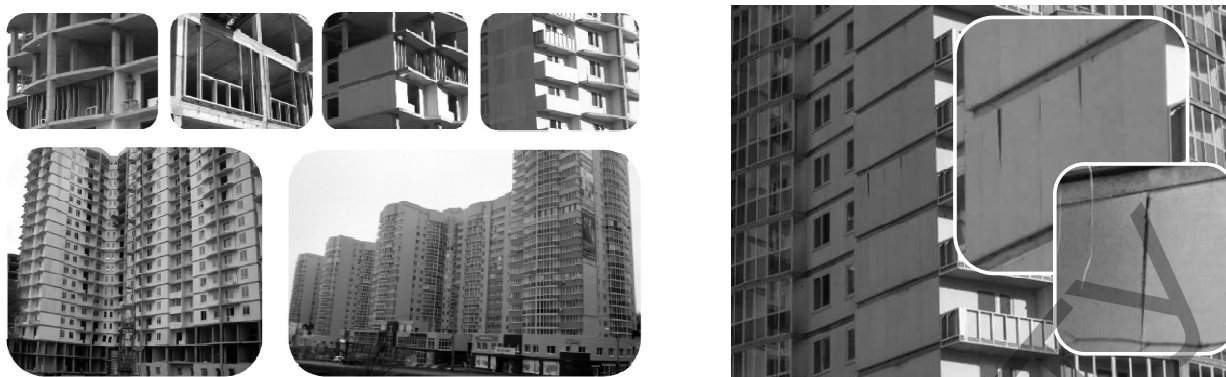
а) общий вид; б) некачественное крепление наружной обшивки из СМЛ Рис. 3. Детальный метод изготовления панелей в 20-этажных зданиях г. Воронеж
