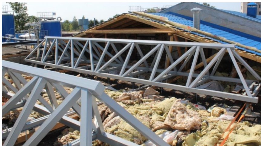
Рис. 2. Общий вид трёхгранных ферм из гнутосварных профилей
