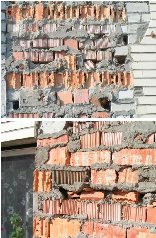
Рис. 5. Состояние кладки основного слоя стены
