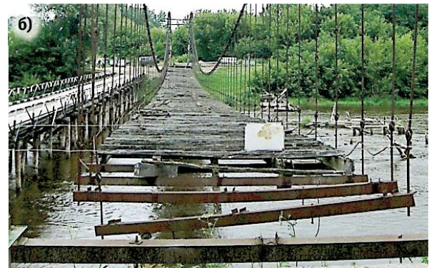
Рисунок 4 – Общий вид крепления подвесок к канатам (а) и провисание полотна моста (б)
