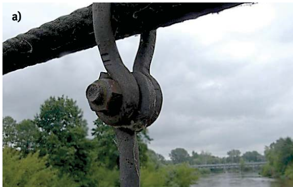
Рисунок 4 – Общий вид крепления подвесок к канатам (а) и провисание полотна моста (б)
