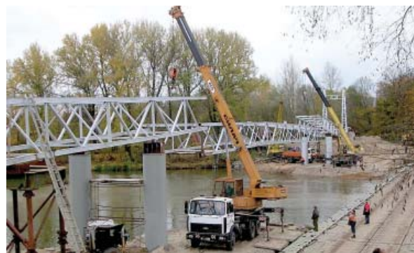
Рисунок 6 – Монтаж центрального пролета моста длиной 60 м двумя кранами ДЭК-251
