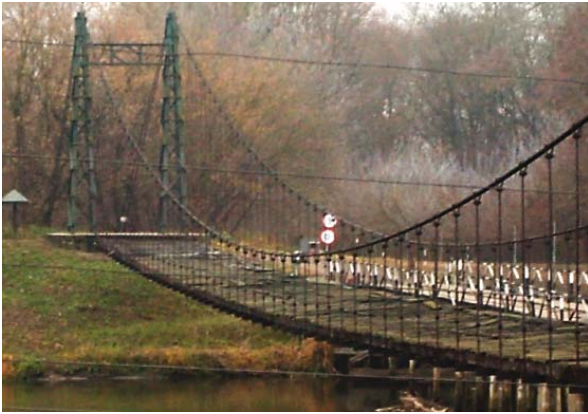
Рисунок 2 – Общий вид моста до реконструкции
