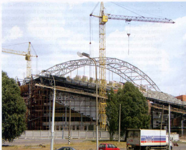
Рис. 5. Общий вид покрытия с испытательной нагрузкой
