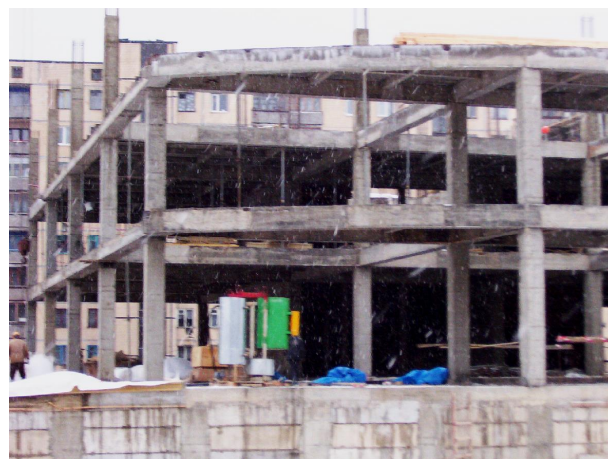
Рис. 1. Монолитный железобетонный каркас
