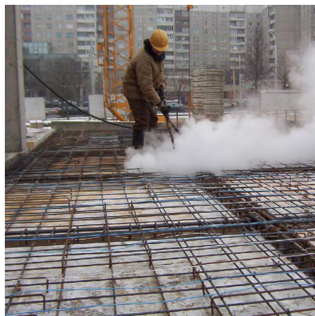
Рис. 2. Раскладка греющего провода и очистка опалубки
