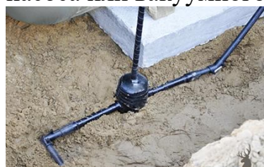
Сборник газового конденсата
