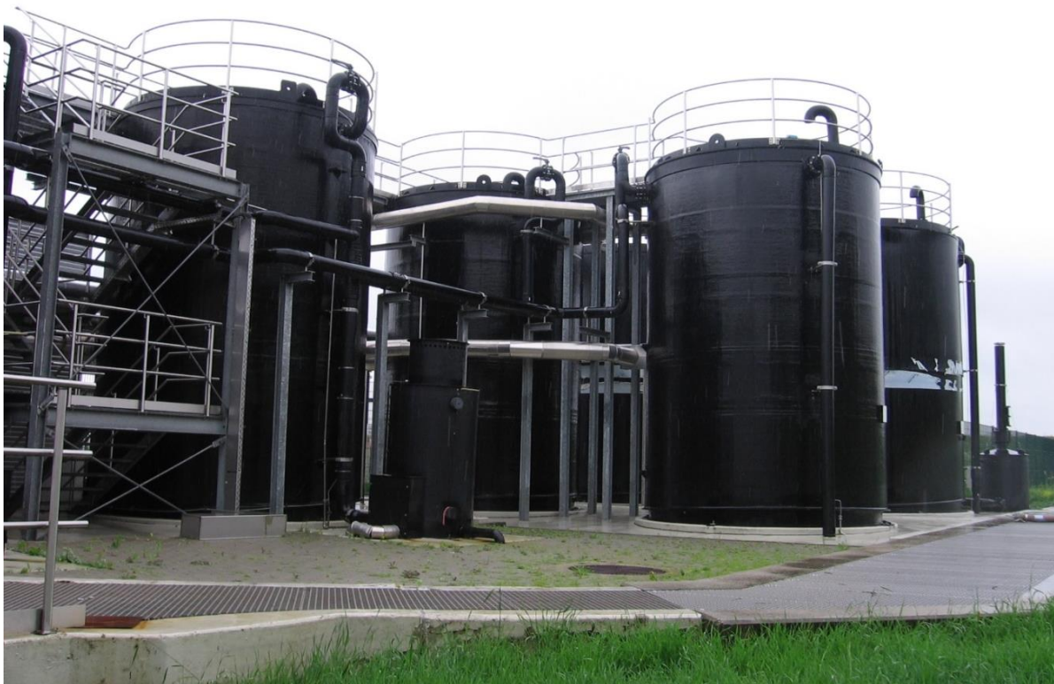
Рисунок 2 — Вид биофильтров для схемы с биологической очистки сточных вод с предварительной денитрификацией
