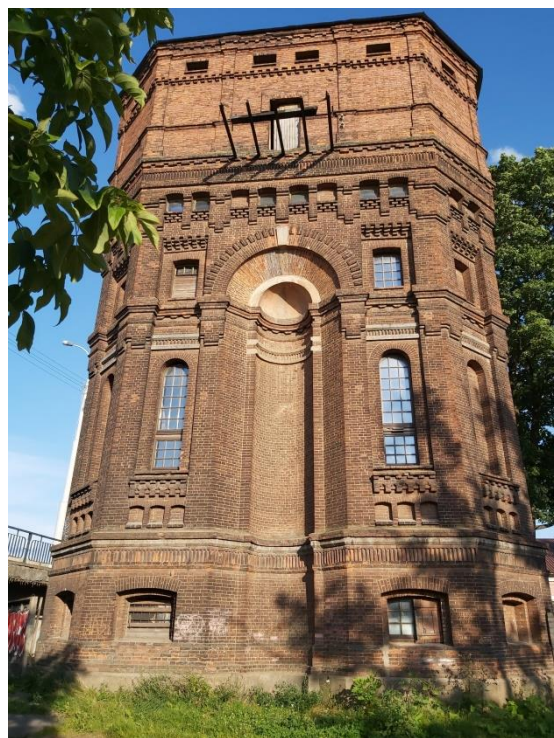
Рисунок 4 — Водонапорная башня начала XX века (Минск, Беларусь)
