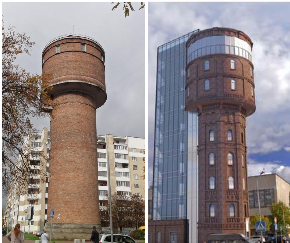
Рисунок 7— Водонапорная башня в черте города в проекте до и после реконструкции (Брест, Беларусь)
