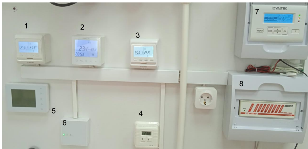
Рисунок 4 – Средства автоматического управления стендом 1 – хронотермостат VT.AC709; 2 – WIFI хронотермостат VT.AC712; 3 – хронотермостат двухконтурный VT.AC711; 4 – термостат VT.AC701; 5 – беспроводной хронотермостат VT.AC707; 6 – приемник хронотермостата VT.AC707; 7 – контроллер VT.K300; 8 – зональный коммуникатор
