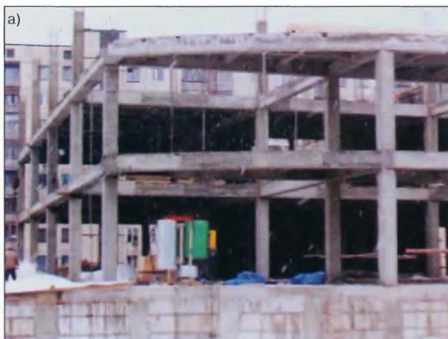
Рисунок 4. Возведение монолитного железобетонного каркаса при строительстве магазина с паркингом по ул. В. Хоружей (г. Минск)
