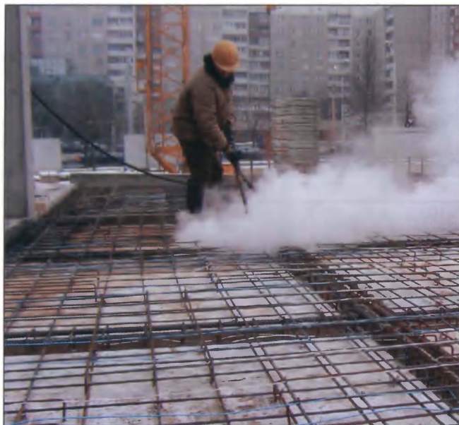
Рисунок 3. Раскладка греющего электропровода и очистка опалубки при возведении перекрытия Бизнес-центра "Европа" по ул. Сурганова (г. Минск)
