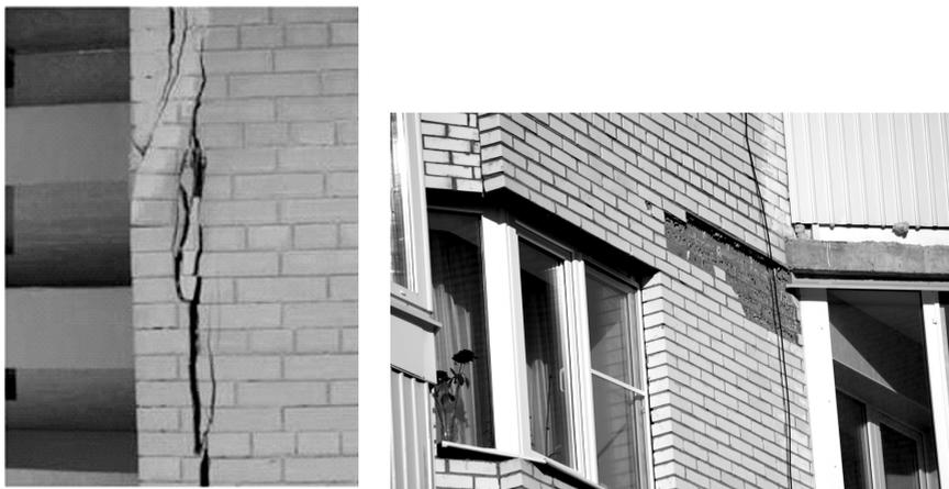
**Рисунок 1.** Характерные повреждения облицовочного слоя многослойных стен
