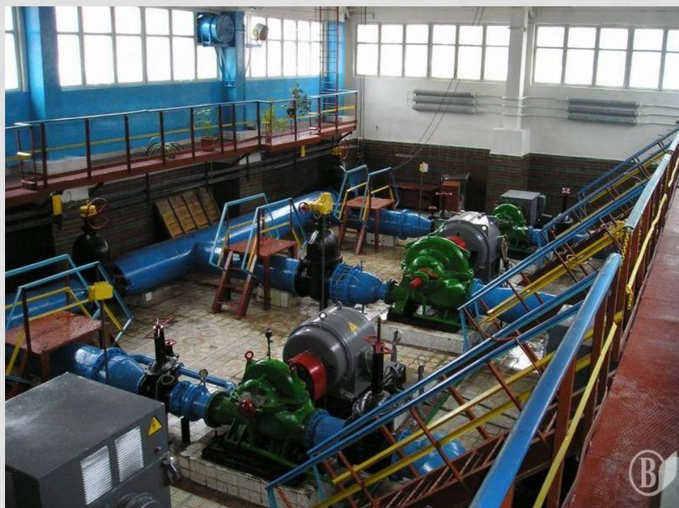
При модернизации и интенсификации работы водозаборных сооружений (с целью увеличения их производительности при возможности увеличения забора воды из источника) возможна замена насосного оборудования на более мощное, установка на существующих насосных станциях дополнительных насосов
