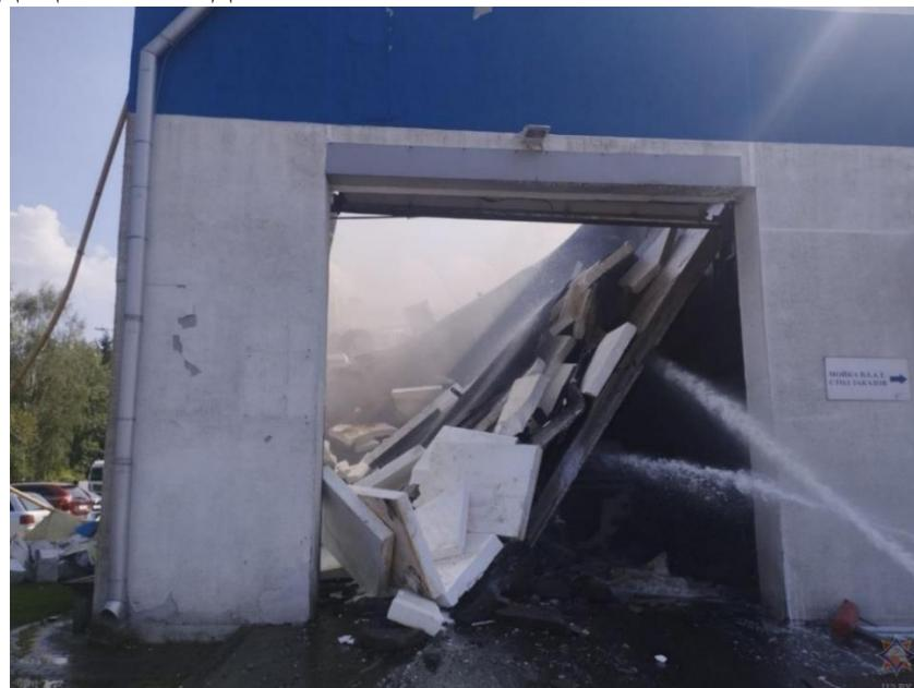
*Рисунок 1 – Вид повреждений здания при дегазации транспортной емкости сжиженного газа при взрыве газовоздушной смеси [3]*
