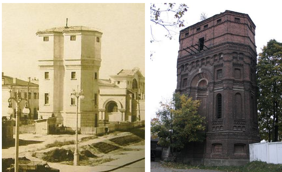
Рисунок 3 – Водонапорные башни на городских улицах Минска (на фото начала XX века и сохранившееся здание по ул. Автоторовской)
