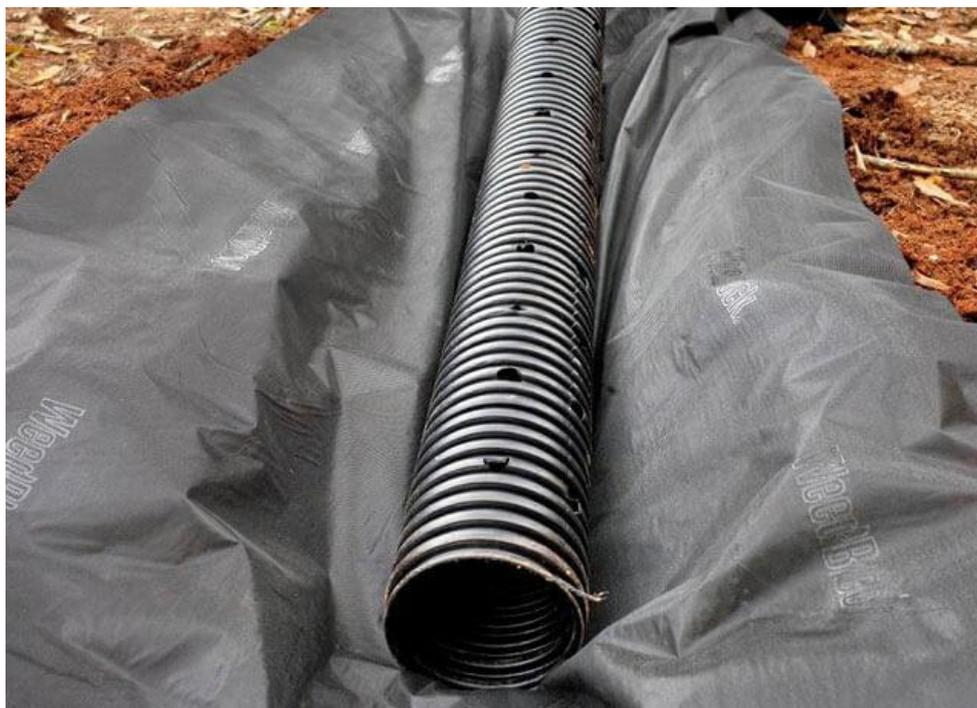
*Рисунок 5 – Пластмассовая дренажная труба*
