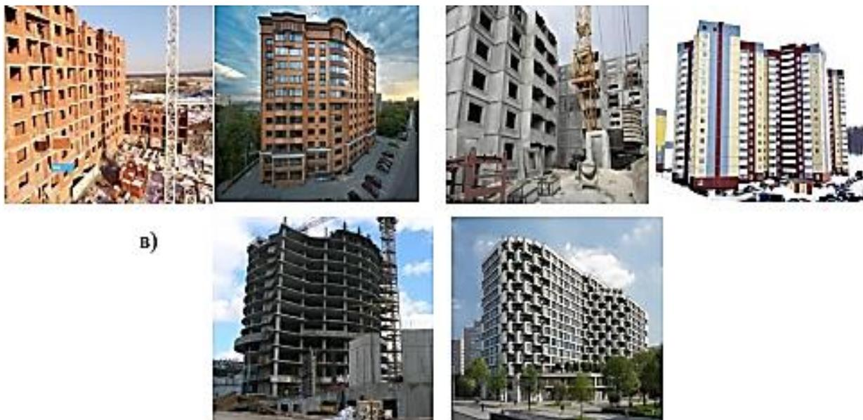
а – сборная ж/б с каменными стенами; б – панельная; в – сборно-монолитная
