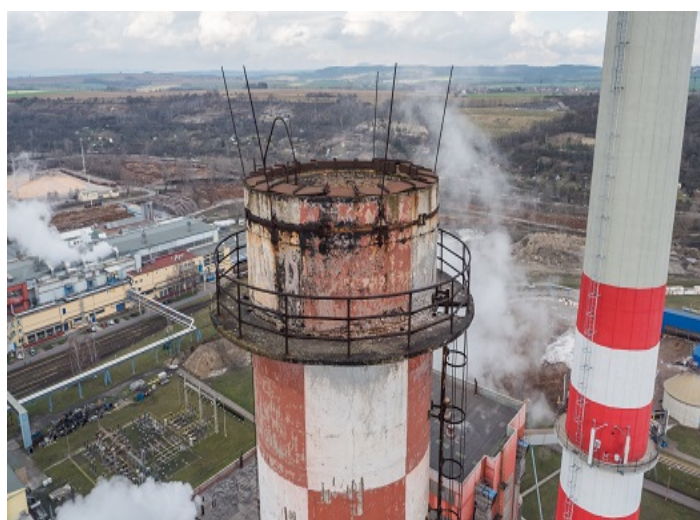
Fot. 11 – Kontrola stanu technicznego komina w zakładzie przemysłowym (urydio: http://udrzapodniku.cz/hlavni-menu/artikuly/artikul/article/bezpilotni-letadla-pri-sprave-budov-a-prumyslovych-arealu/ ).
