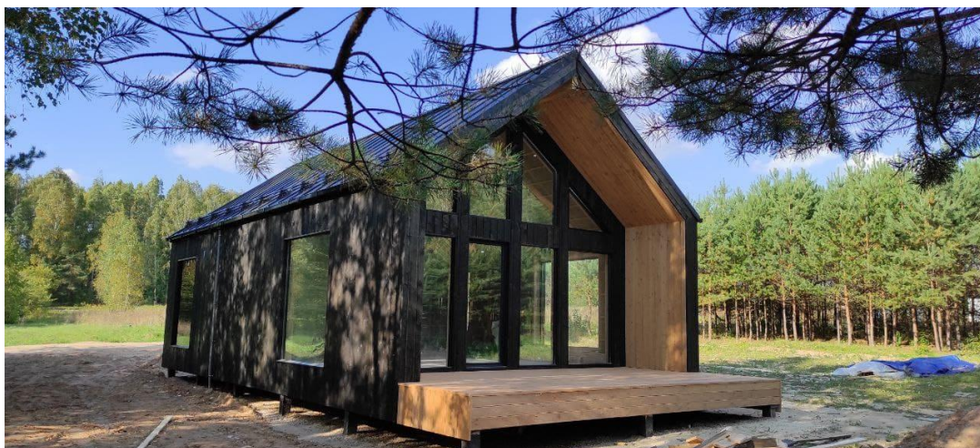
Рисунок 2 – Барнхаус, изготовленный по панельной технологии в городе Гродно [2]
