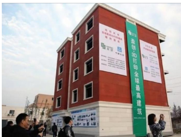
Рисунок 1 – Многоэтажный дом, напечатанный с помощью 3D-принтера компанией WinSun [1]
