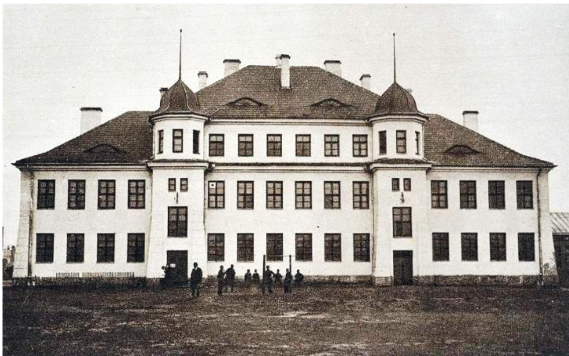
Улица Папанина, 4/1. Szkoła techniczna. Постройка 1923 года. Арх. С. Сидорчук
