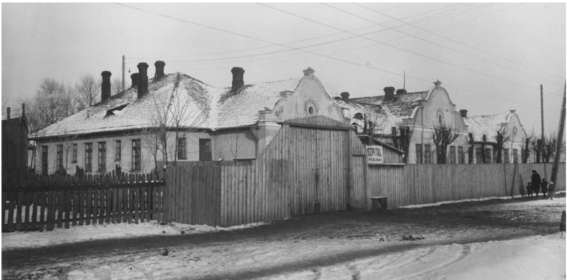
Городская больница на Городке. Постройка конца XIX века (Фото 1920-х)
