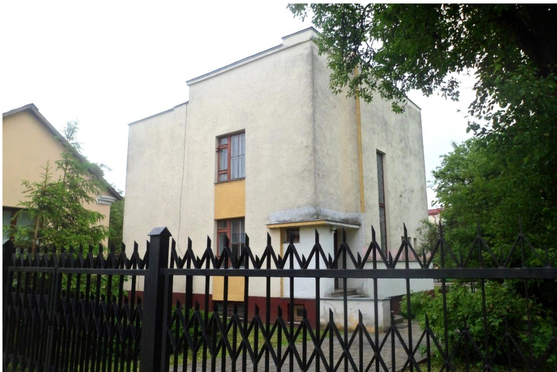
Улица Пушкинская, 65/1. Дом директора Szkoły Technicznej. Постройка 1930-х годов. Арх. Ю. Бараньски (Фото 2018)
