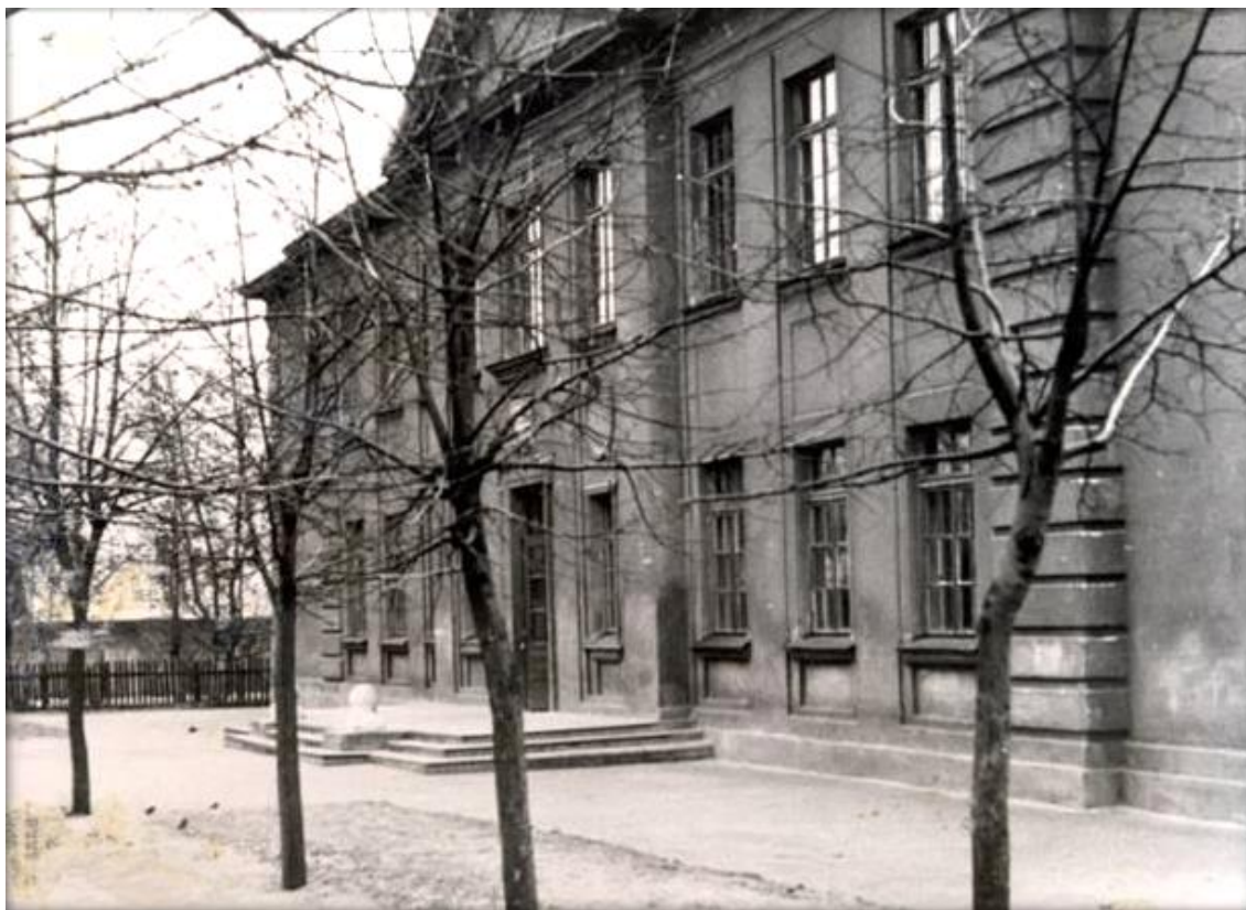
Улица Гурова, 28. Железнодорожная школа № 40 (СШ № 17). Постройка 1953 года (Фото 1950-х)
