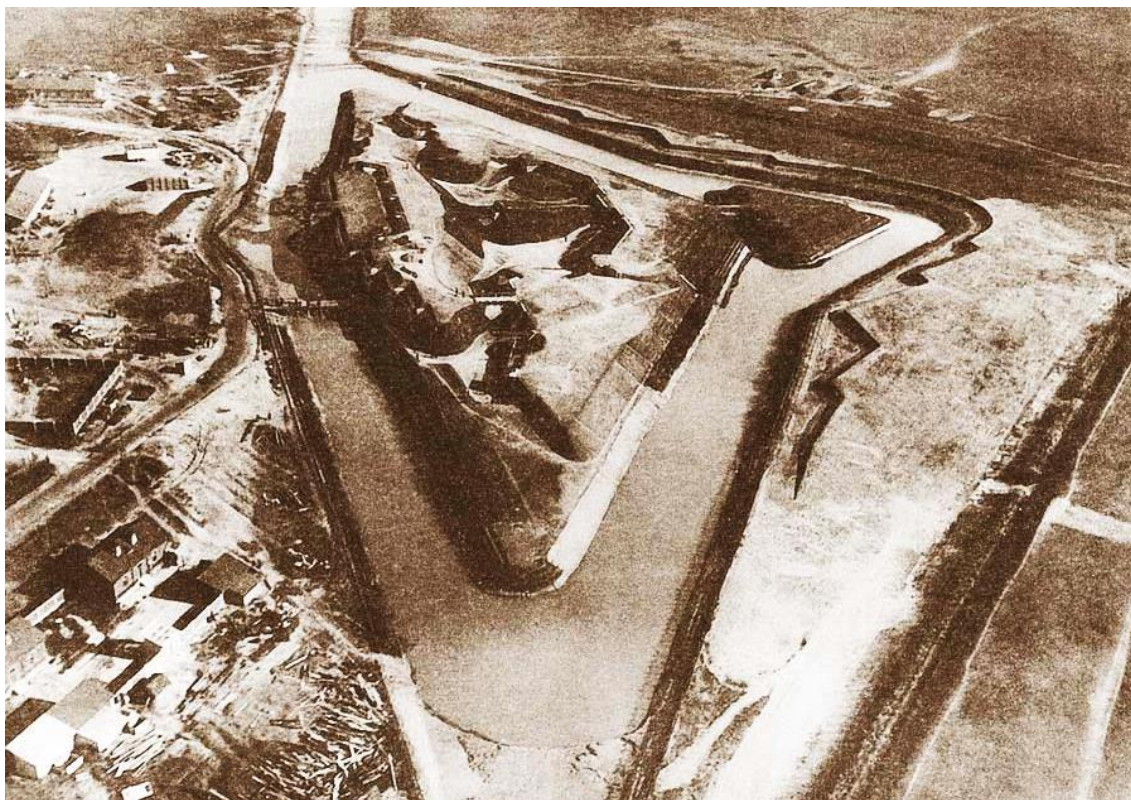
Форт литера «Ж» (Фото 1915)
