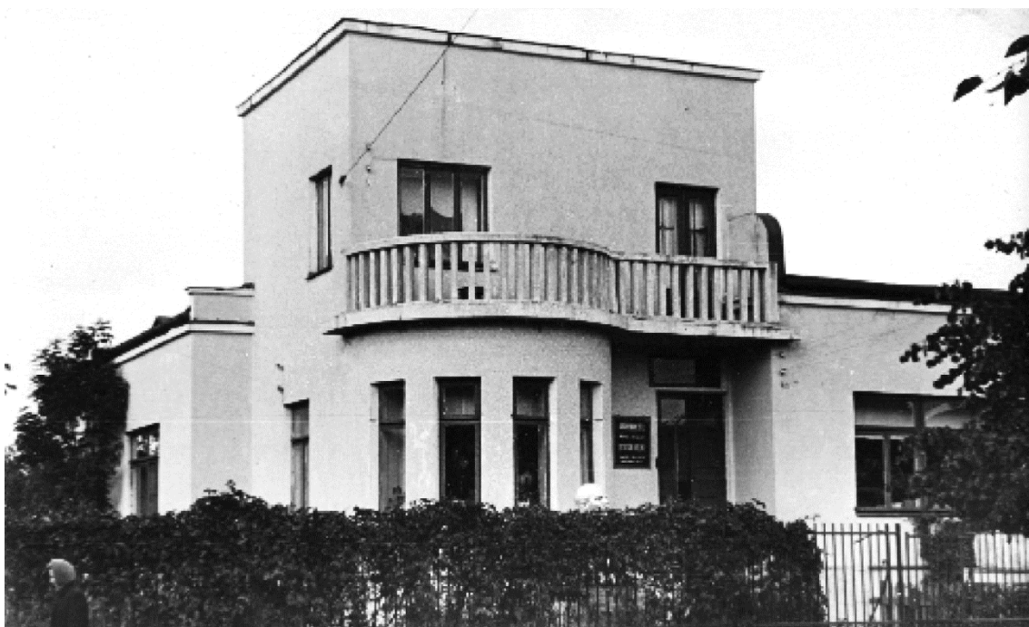
Улица Пушкинская, 42. Особняк доктора Леонарда Шпарло. Арх. Б. Рымкевич. Постройка 1936 года (Фото 1962)
