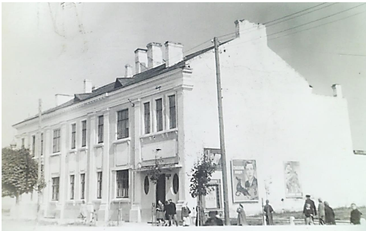
Улица Советская, 18. «Bank dla Handlu i Przemysłu w Warszawie». Постройка 1923 года. Арх. С. Сидорчук
