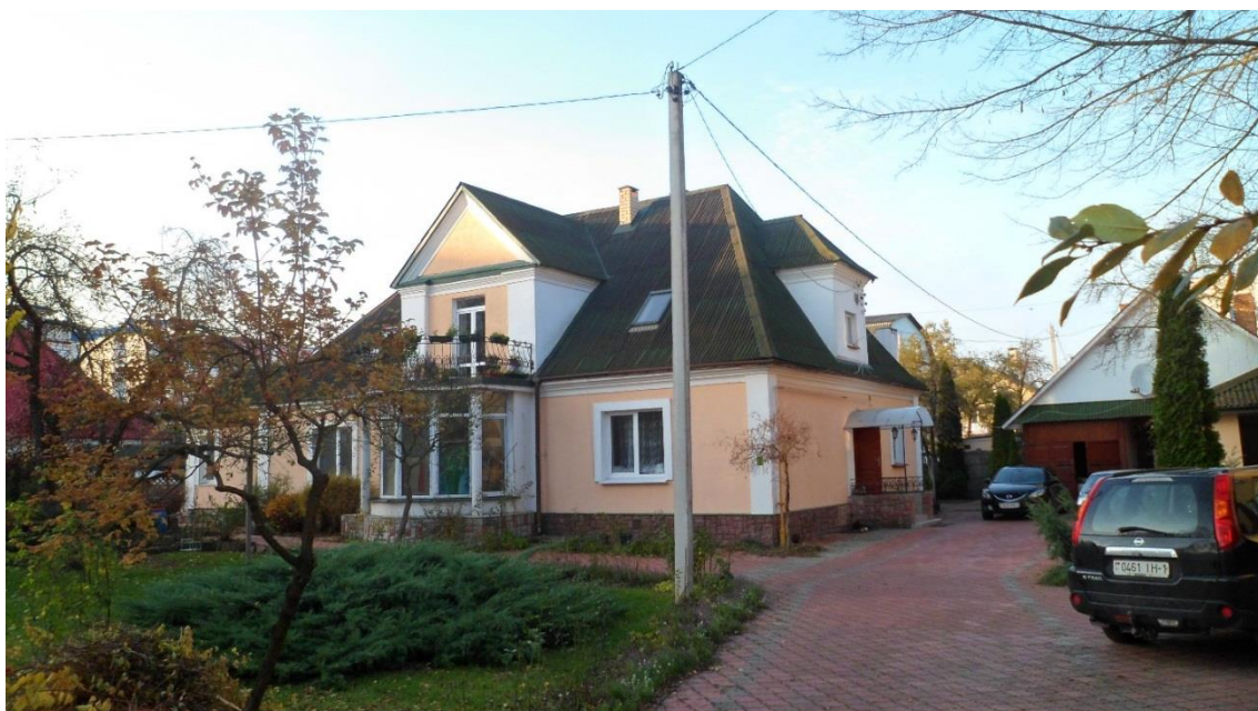
Улица В. Хоружей, 11. Постройка 1923–1924 годов. Арх. Ю. Лисецкий (Фото 2017)
