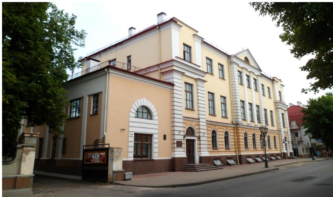
Улица Орджоникидзе, 14. «CENTRALIA SPIRITUSOWA «POZNAN». Постройка 1924 года. Арх. Кухарский. Реконструкция в 1930 году. Арх. Ю. Бараньски (Фото 2017)
