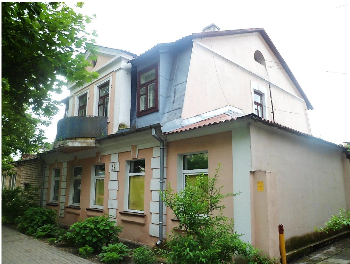
Улица Кирова, 69. Дом архитектора Е. Письменского 1924 года. Арх. С. Сидорчук (Фото 2018)
