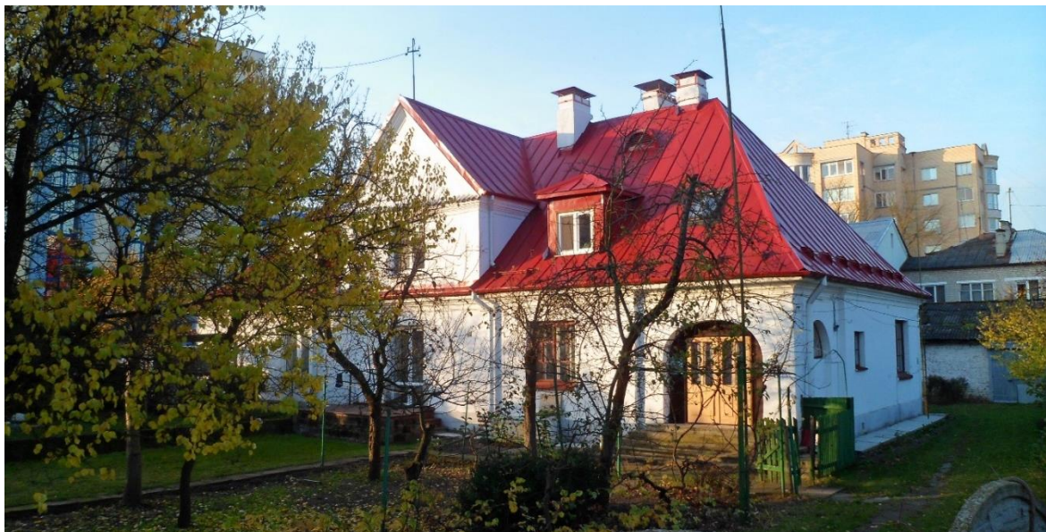
Улица В. Хоружей, 13. Постройка 1923–1924 годов. Арх. Ю. Лисецкий (Фото 2017)
