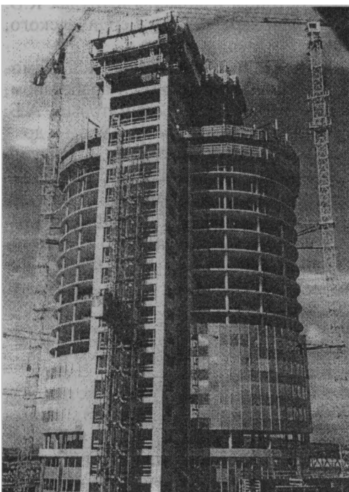
Рис. 2.9. Применение сборного и монолитного железобетона в современном высотном строительстве – «Башня тысячелетия» («Millennium Tower», Вена), высотой 202 м
