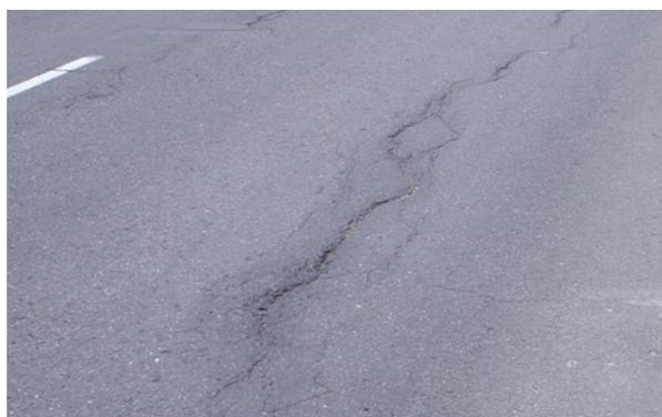
Продольное трещинообразование усталостного характера
