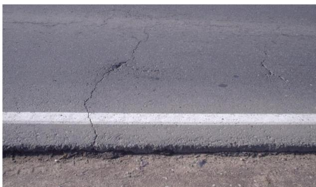
Поперечное трещинообразование усталостного характера
