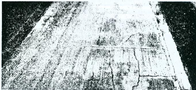
Рис. 29.2. Трещины в цементобетонном покрытии
