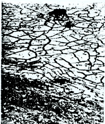
Рис. 8.9 Трещины усадки глинистых грунтов.
