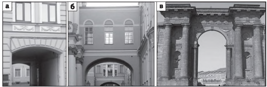
Рис. 1. Каменные арки в домовых проездах (а), в качестве несущих конструкций галерей (б) и архитектурных элементов (в)
