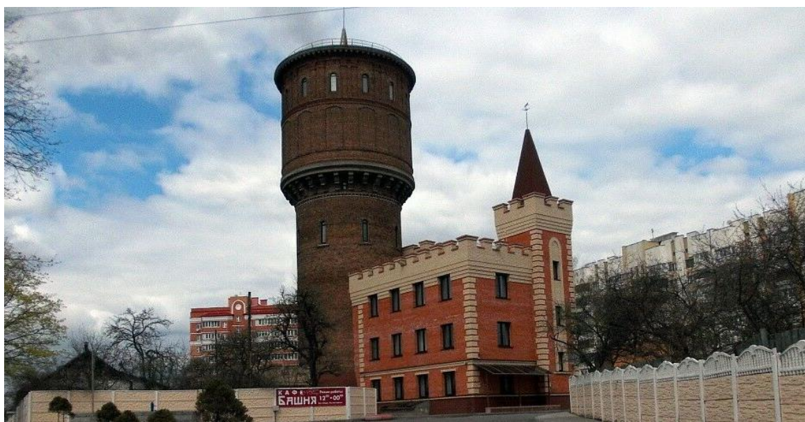
Рисунок 3 – Водонапорная башня (Гомель, Беларусь)
