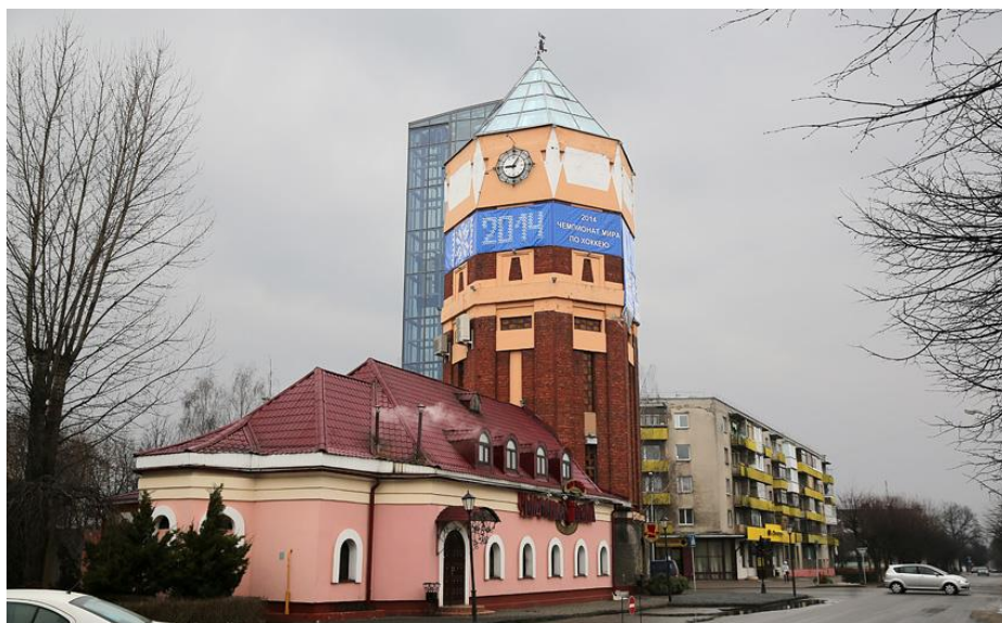
Рисунок 2 – Водонапорная башня (Бобруйск, Беларусь)
