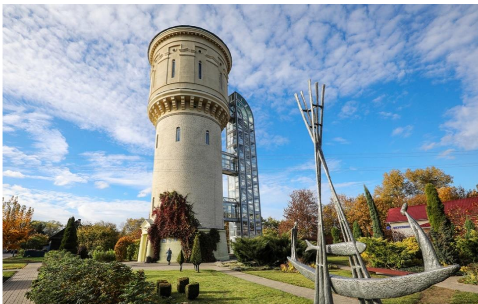
Рисунок 4 – Водонапорная башня (Полоцк, Беларусь)
