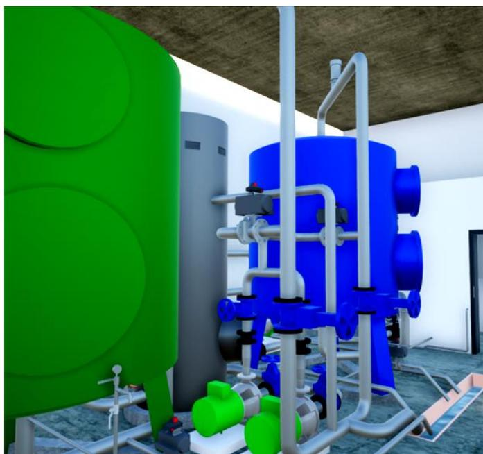
**Рисунок 3 – Фильтр станции водоподготовки**
