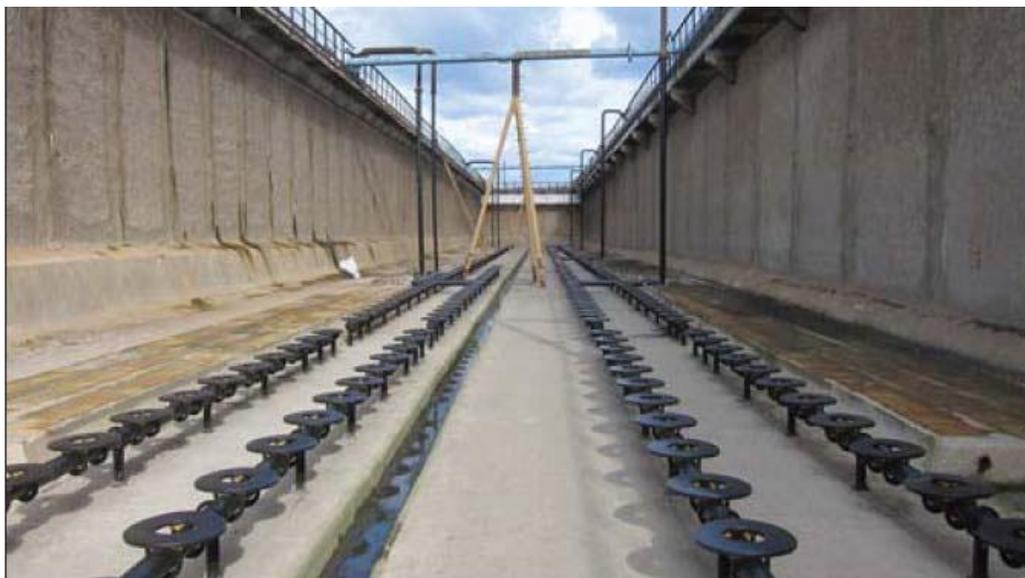
*Рисунок 1- Аэраторы АКВА-ТОР в аэротенках на Люберецких очистных сооружениях АО «Мосводоканал» [9]*
