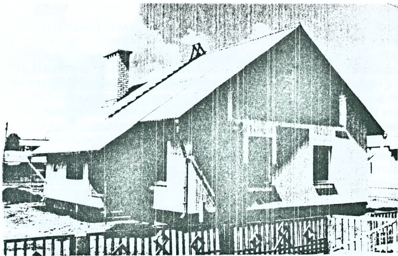
Рис. 2.6 Одноквартирный жилой дом с внешним входным тамбуром в населённом пункте Новка Витебской района.
