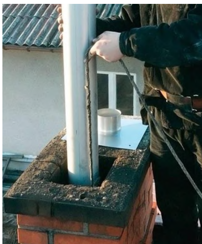
Рисунок 1 – Загильзовка кирпичного дымохода
